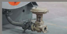
قابلیت نصب شیر اتوماتیک زیرآبزی بصورت تایمردار Automatic Bottom Blowdown Valve
